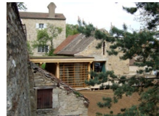
L'extension se glisse contre le mur voisin
